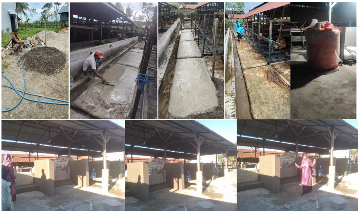
Gambar 3. Redisain lantai kandang untuk sapi jantan untuk mengalirkan urin sapi (atas); Pembuatan dinding pembatas dan lantai kandang untuk sapi betina (bawah)
